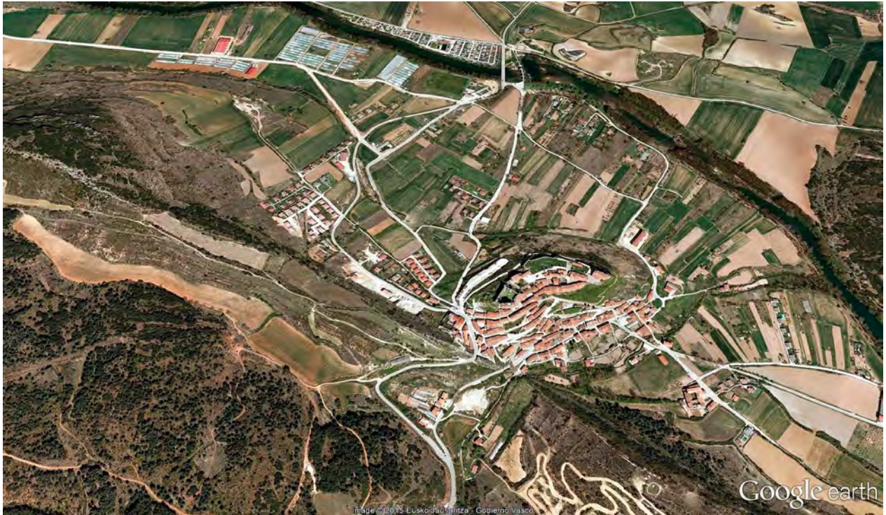
Imagen del Google del entorno de Frías donde puede observarse el desarrollo de urbanizaciones y el camping junto al puente que ha sido destruido por la crecida del Ebro a fines de enero de 2015 y que, en consecuencia ha sido prohibido por la Confederación Hidrográfica del Ebro.
