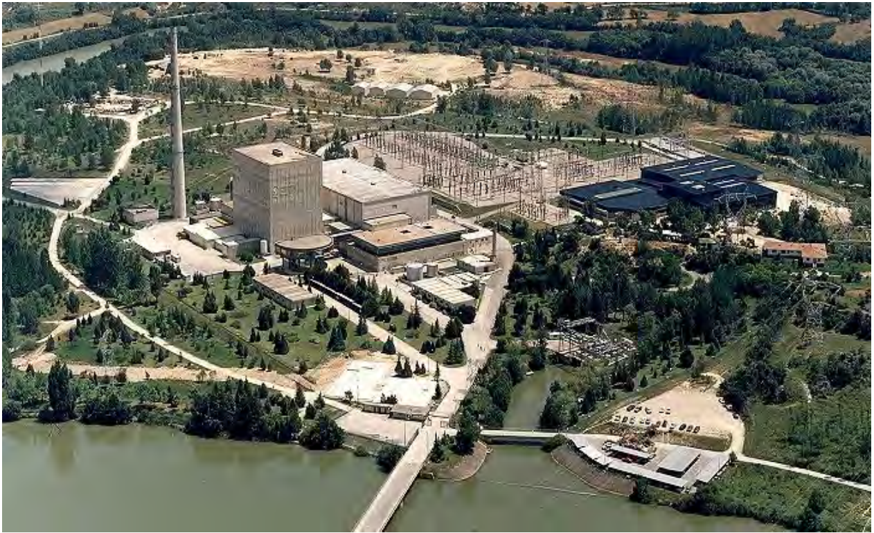
Central Nuclear Santa María de Garoña. En primer plano el bloque del reactor y la chimenea , tras el la planta de trabajo y el parque de salida de líneas
